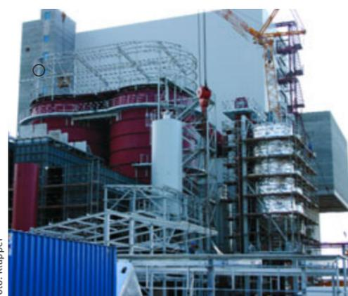
Baufortschritt MHKW Rothensee. Die Rauchgasreinigungsanlage mit Sprühabsorber und Gewebefilter.
